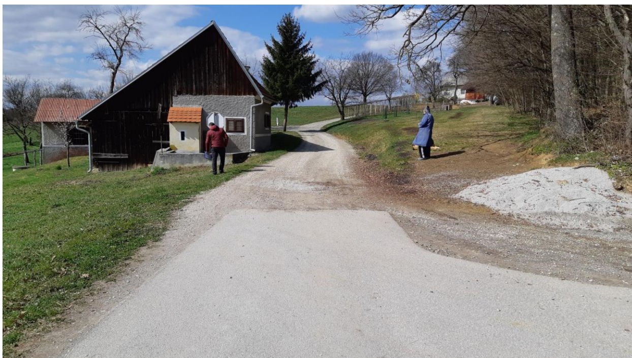
Slika 4: zaključek trase - navezava na obstoječi asfalt; pogled v nasprotni smeri stacionaže
